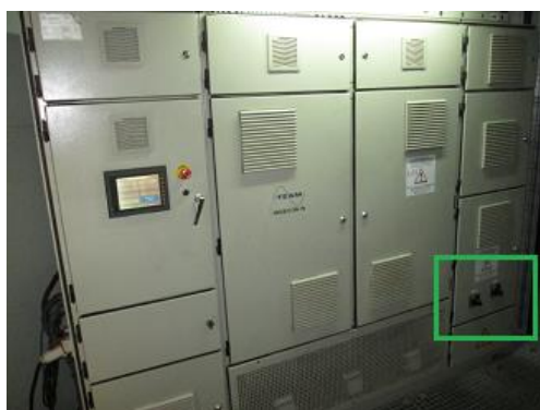
Armario ground, resaltado en verde la ubicación del interruptor Q5.
