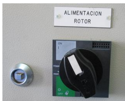
Interruptor Q5 – Alimentación Rotor cerrado, en condiciones de operación.
