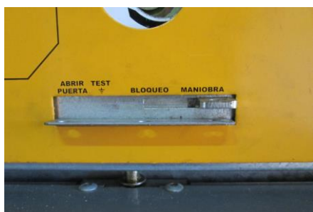
Detalle del selector de bloqueo: posición "MANIOBRA".
