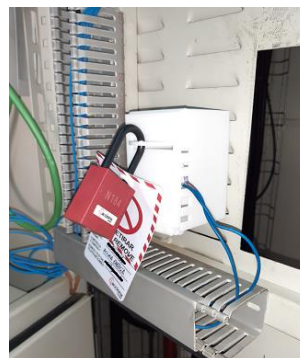
Consignación de la alimentación de 24V del display Lock out and tag out of the 24V power supply at the display
