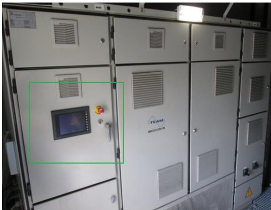
Armario ground, señalado en verde el panel de control.
